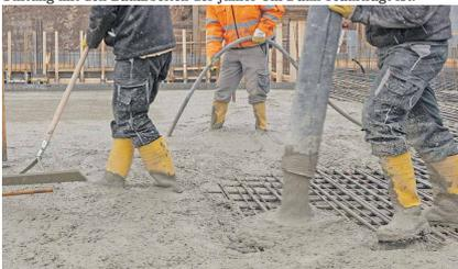
In der Bodenplatte der Junior Uni Daun wurden 350 Kubikmeter Beton und rund 100 Tonnen Bewehrungsstahl verbaut.
